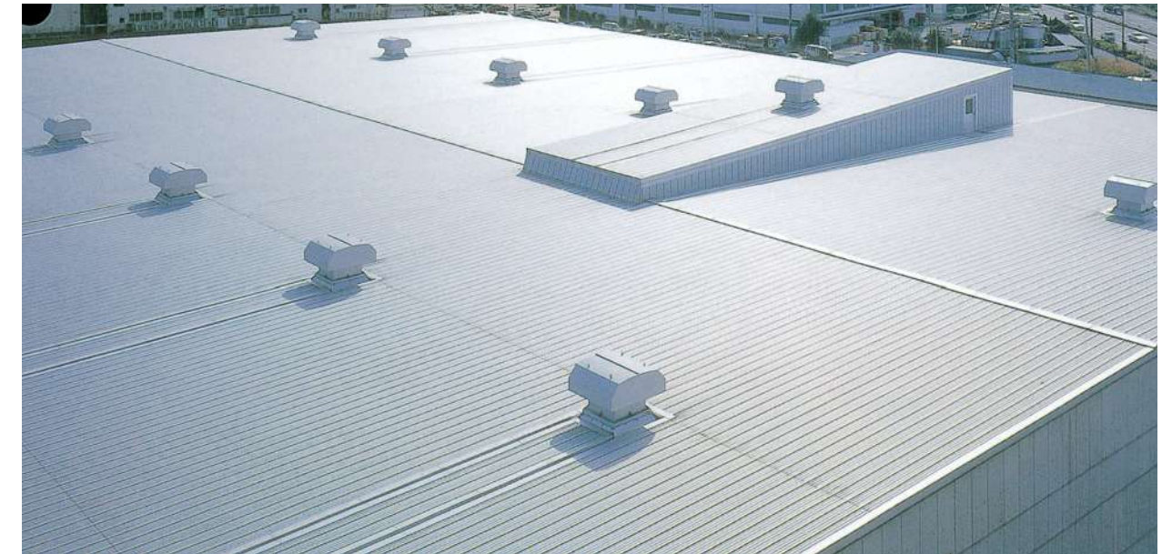
改修例 (サビが浮き、劣化が進んだ屋根をメタコルーフATで改修)
